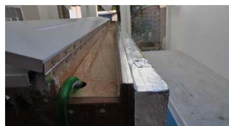
Goot waar straks leidingen door lopen
